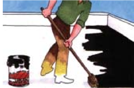
Şekil 4: Betonarme yüzeylerin bitüm ile astarlanması
